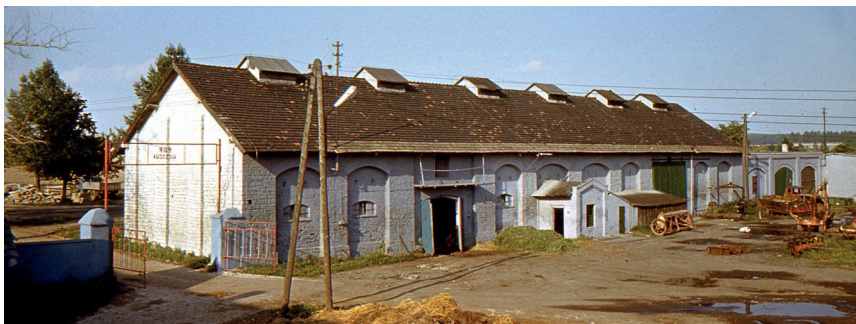
Fot. 8. Budynki po północnej stronie podwórza
