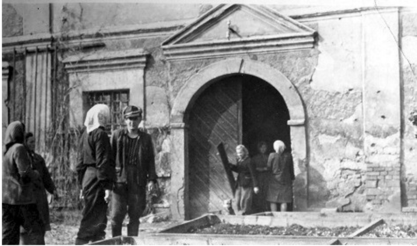
Fot. 4. Portal pałacu z drzwiami klepkowymi
