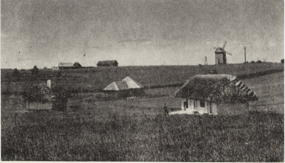
Ryc. 40. Park Etnograficzny w Tokarni — widok ogólny od strony Chęcin. Stan z 1982 r.
