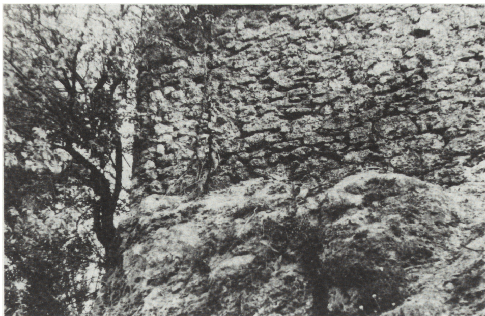
Ryc. 9. Posadowienie południowej części muru zamkowego na skale
