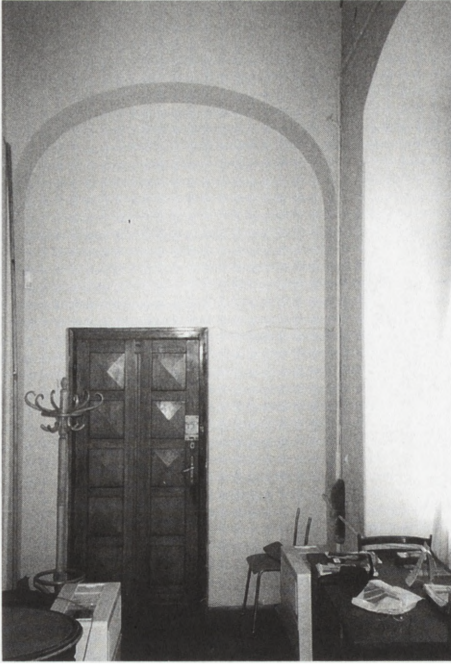
9. Ściana północna pomieszczenia po pierwszej kaplicy. Jej cieńsza część, zamknięta eliptycznym łukiem ponad, wyznacza wielkość pierwotnego bezdrzwiowego przejścia między sienią górną a kaplicą.
