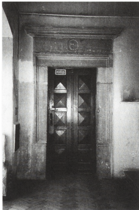
8. Portal z herbem Łabędź bpa Trzebieckiego. W latach 1663-1667 wstawiony w zmniejszone wówczas wejście do pomieszczenia po byłej pierwszej kaplicy. Po włączeniu jej w ciąg komunikacyjny, łączący pałac ze skrzydłem południowym (w XVIII wieku), wmontowany w ścianę południową.
