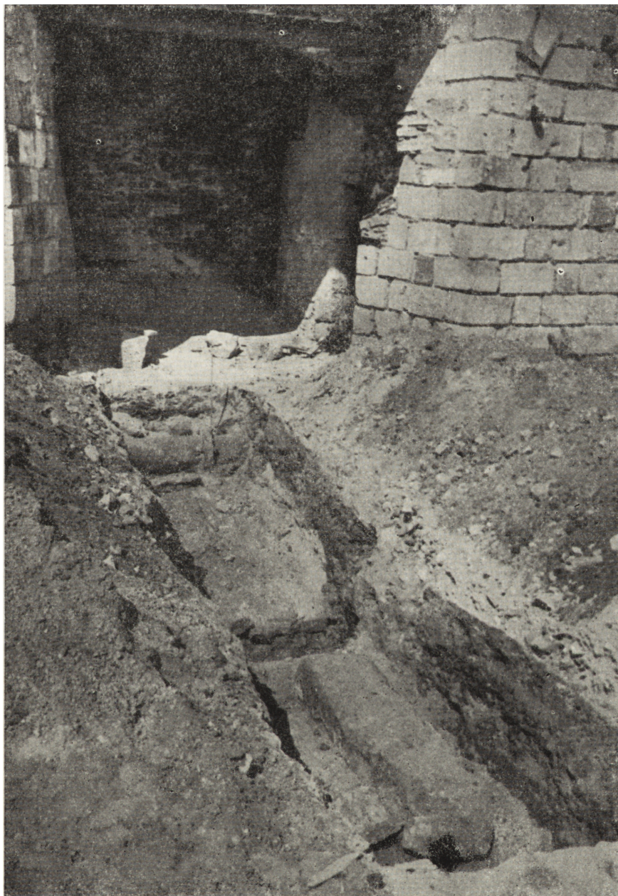
Ryc. 3. Wykop I. Kolejno od strony patrzącego: blok kamienia prawdopodobnie związany funkcjonalnie z działającym w odlewni żeliwniakiem; górna krawędź sklepienia podziemnego korytarzyka; rura doprowadzająca dmuch do wielkiego pieca
