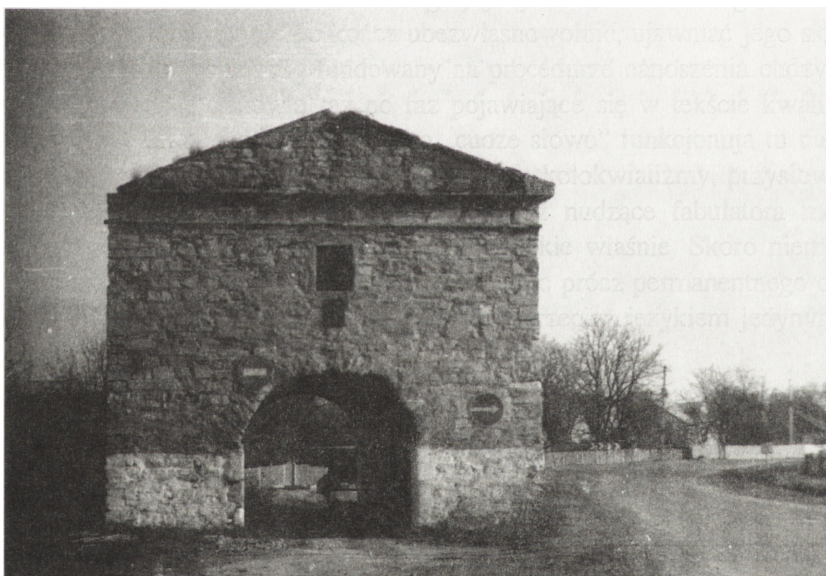
Brama Kamieniecka (fasada zachodnia)
