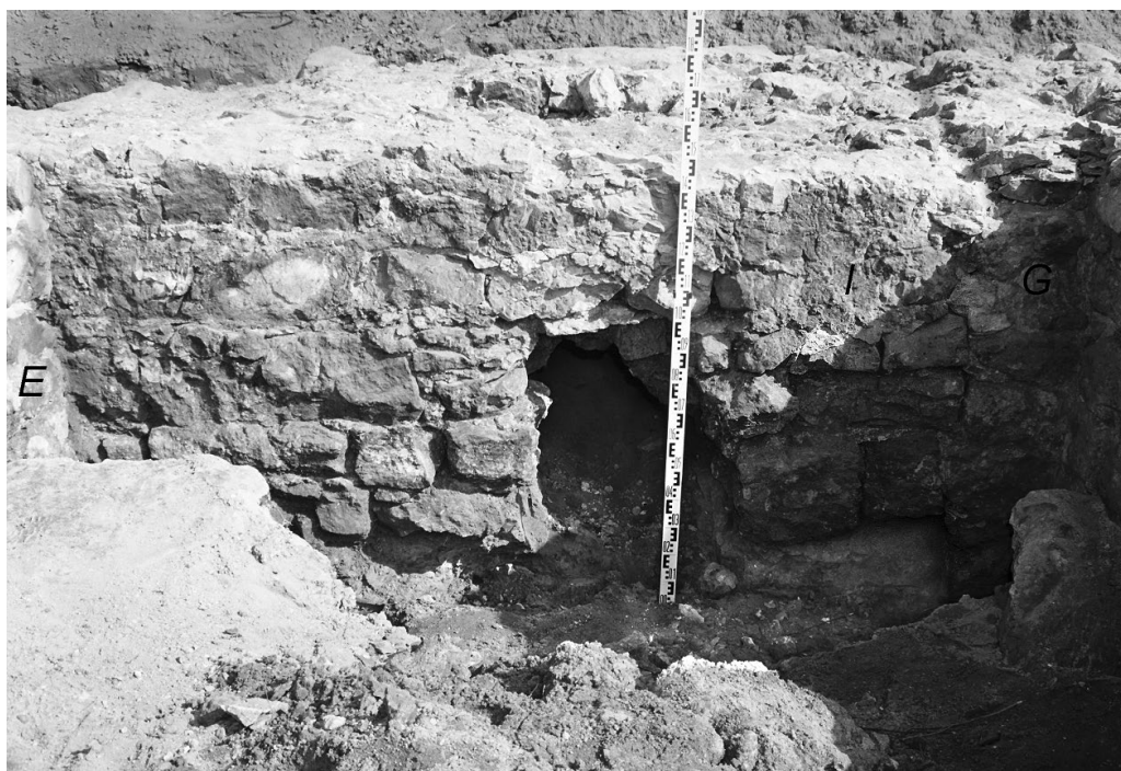
Fot. 3. Ściana wschodnia budowli wieżowej (fot. M. Ignasiak).
