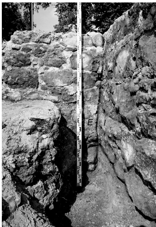
Fot. 4. Połączenie ściany północnej ze wschodnią w budowli wieżowej (fot. M. Ignasiak).
