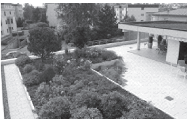
Zdjęcie 3. Zieleni wykonana na dachu budynku
