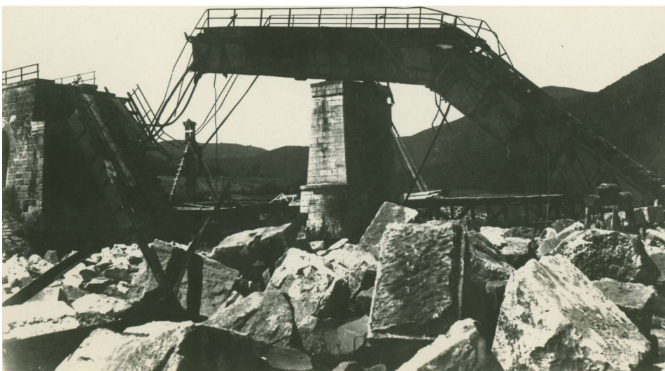
Fot. 3. Widok zniszczonego przez partyzantów słowackich mostu kolejowego na trasie Prešov–Kysak 1944 r.
