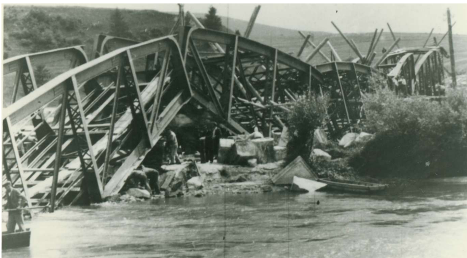
Fot. 1. Widok mostu kolejowego w Trnave wraz z wagonami po akcji dywersyjnej, 1944 r. Źródło: Múzeum SNP Banská Bystrica, Číslo negatívu: 583/67
