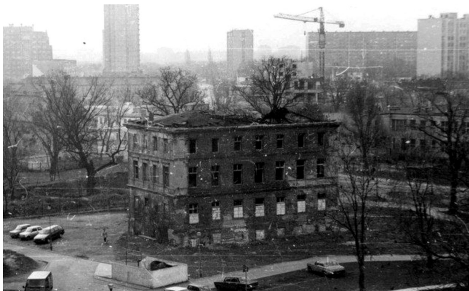
Fot. 4. Budowa blokowisk na Nowym Dworze. W centrum ruiny pałacyku. Druga połowa lat osiemdziesiątych XX wieku
