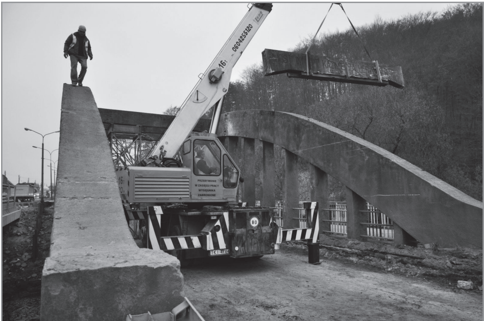
5. Demontaż tężników od strony Kielc, 15.11.2011 r.
