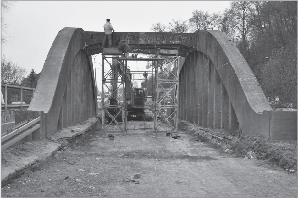
4. Przygotowanie do wycinania tężnika, 15.11.2011 r.
