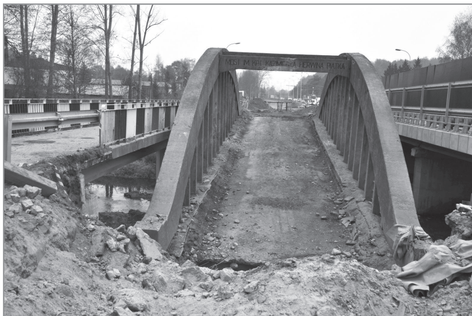
6. Przeszło po wysadzeniu przyczółka mostu, 21.11.2011 r.
