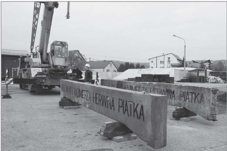
9. Skrajne teźniki mostu przechowywane w bazie Rejonu Dróg Wojewódzkich, oddział w Zgórsku, przygotowane do renowacji, 24.10.2016 r..
