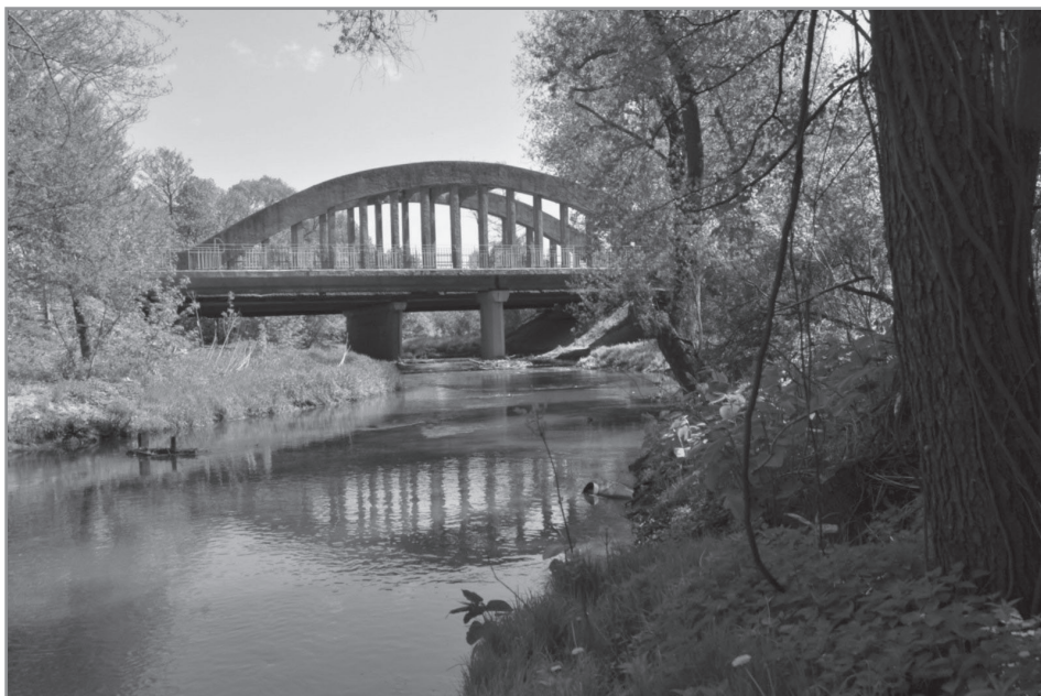
2. Rzeka Bobrza, widok na most od strony ulicy Zalesie; widoczne podpory są elementami kładki i mostu na lewej jezdni drogi 762; 2.08.2011 r.
