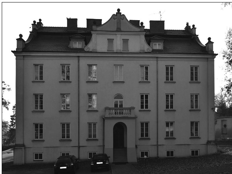
Widok od strony południowej
