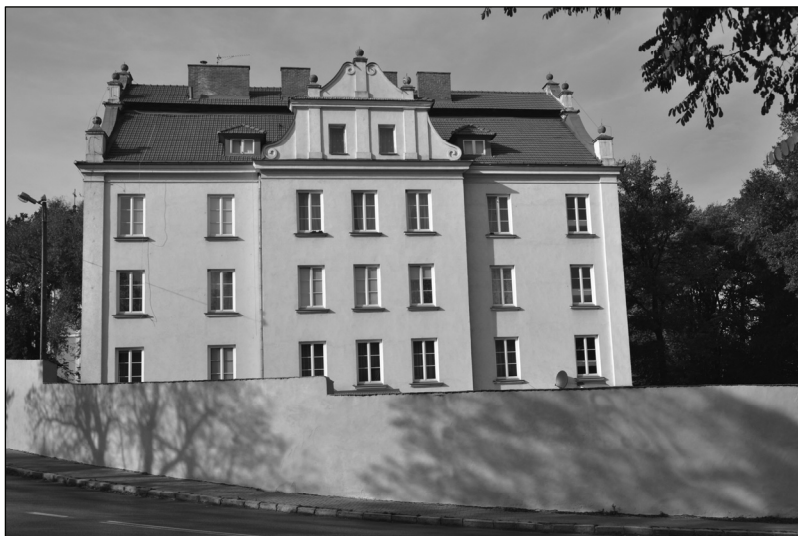
Widok od strony północnej
