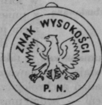
Rys. 11. Oznaczanie punktów stałych zwanych reperami.
