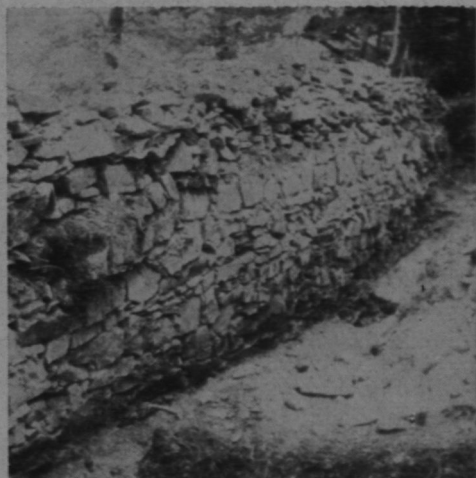
Ryc. 13. Poznachowice Górne, pow. Myślenice. Ściana odkopanego muru. Na wierzchu złożone kamienie z wykopu przy murze.
