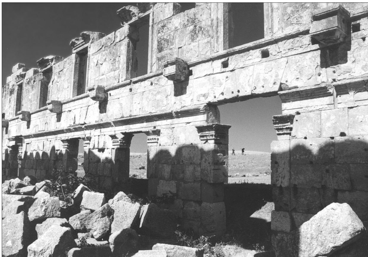
Ryc. 4. Fragment ściany portyku wschodniego Wielkiej Kolumnady w Apamei nad Orontesem. (fot. aut.)
