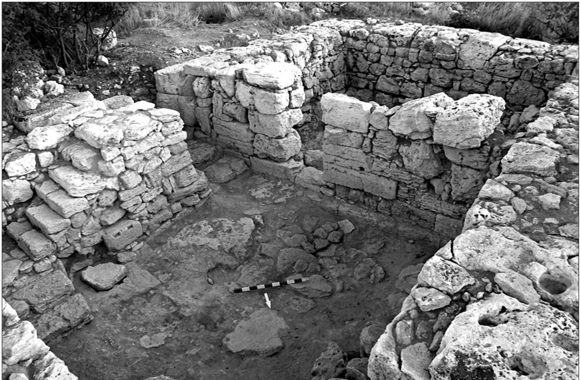
Рис. 2. Сельская усадьба 363. Каменная лестница и колодец (?) в помещении 1 башни (Фот. Т. Сарновски).
