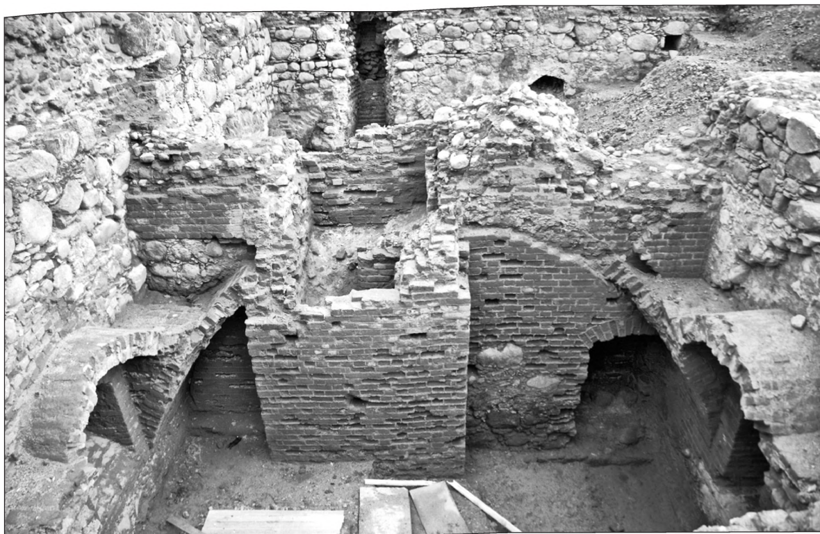
Ryc. 3. Widok południowej części piwnic wschodniego skrzydła Zamku Wysokiego odsłoniętego w 2011 r. (fot. M. Starski). Fig. 3. View of the southern part of the cellars of the eastern wing of the High Castle (exposed in 2011).
