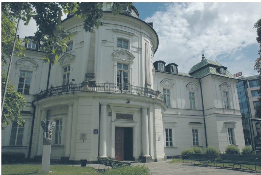
Il. 1. Pałac Przebendowskich w Warszawie, stan obecny, fot. Marzena Królikowska-Dziubecka
