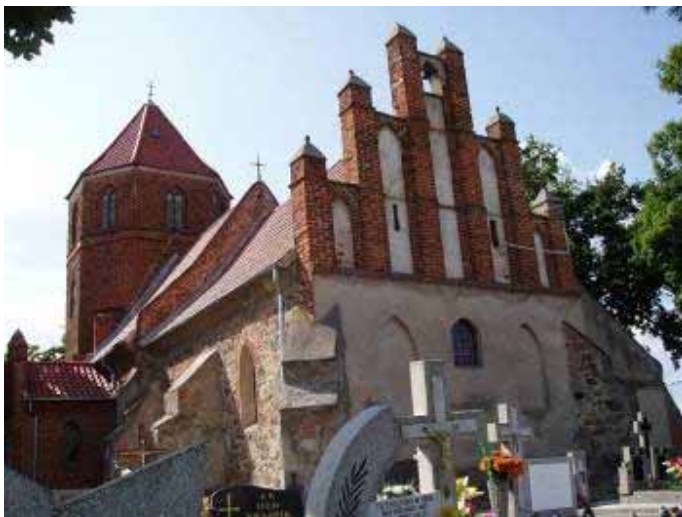
Foto 25. Widok kościoła w Niedźwiedziu od pd.-wsch.
