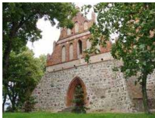
Foto 3. Zachodnia elewacja kościoła w Wabczu.
