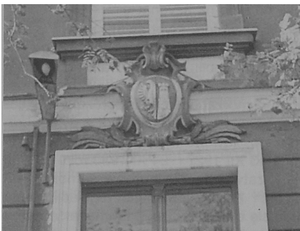
Fot.10. Kartusz nad wejściem głównym do Szkoły Podstawowej nr I (ul. Sienkiewicza), dawniej szkoła żeńska.
