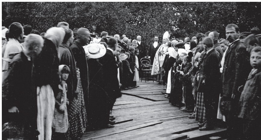
Poświęcenie kamienia węgielnego pod budowę Domu Opatrzności Bożej w Wadowicach, 8 sierpnia 1905 r. (foto. Archiwum Prowincji Krakowskiej Nazaretanek w Krakowie)
