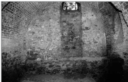
Ryc. 2 Zachodnia piwnica w paśmie środkowym, widok na przebudowaną ścianę zachodnią – stan dzisiejszy.
