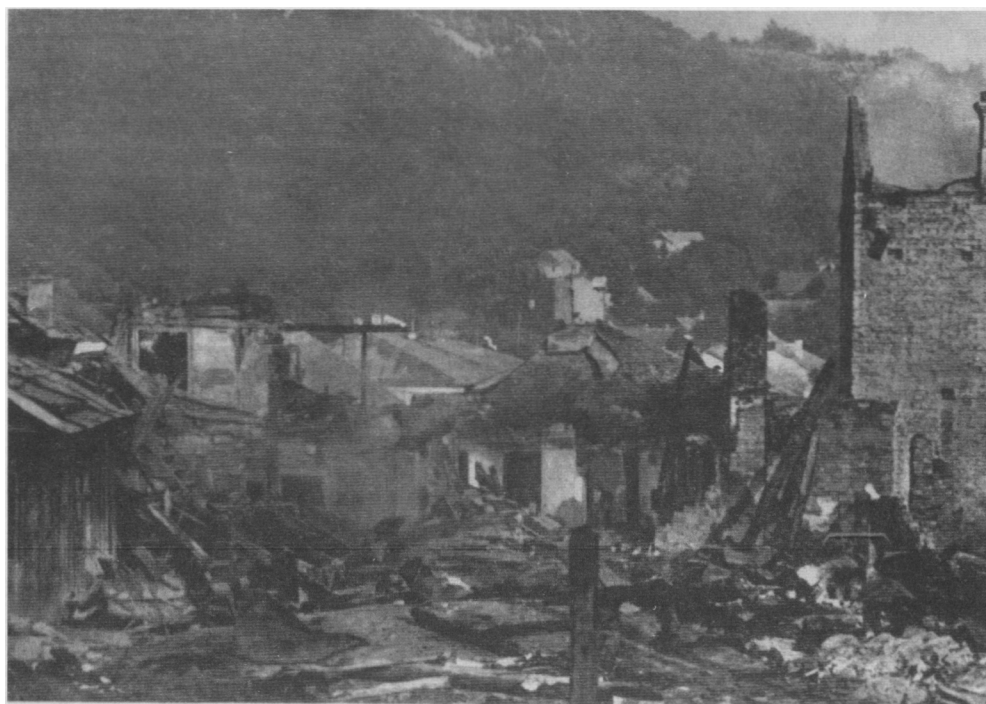
Zniszczony Krzemieniec, zbiory Zygmunta Wałkowskiego
