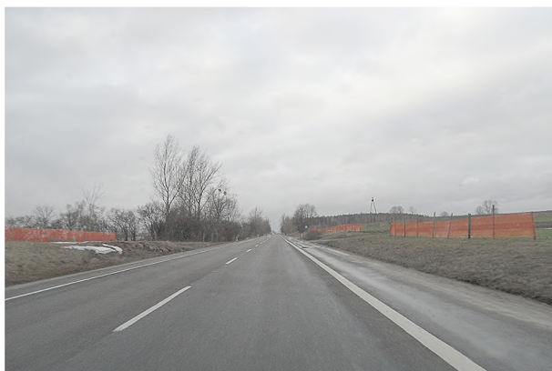
Rys. 1. Sztuczna osłona przeciwnieżna na poboczu drogi
