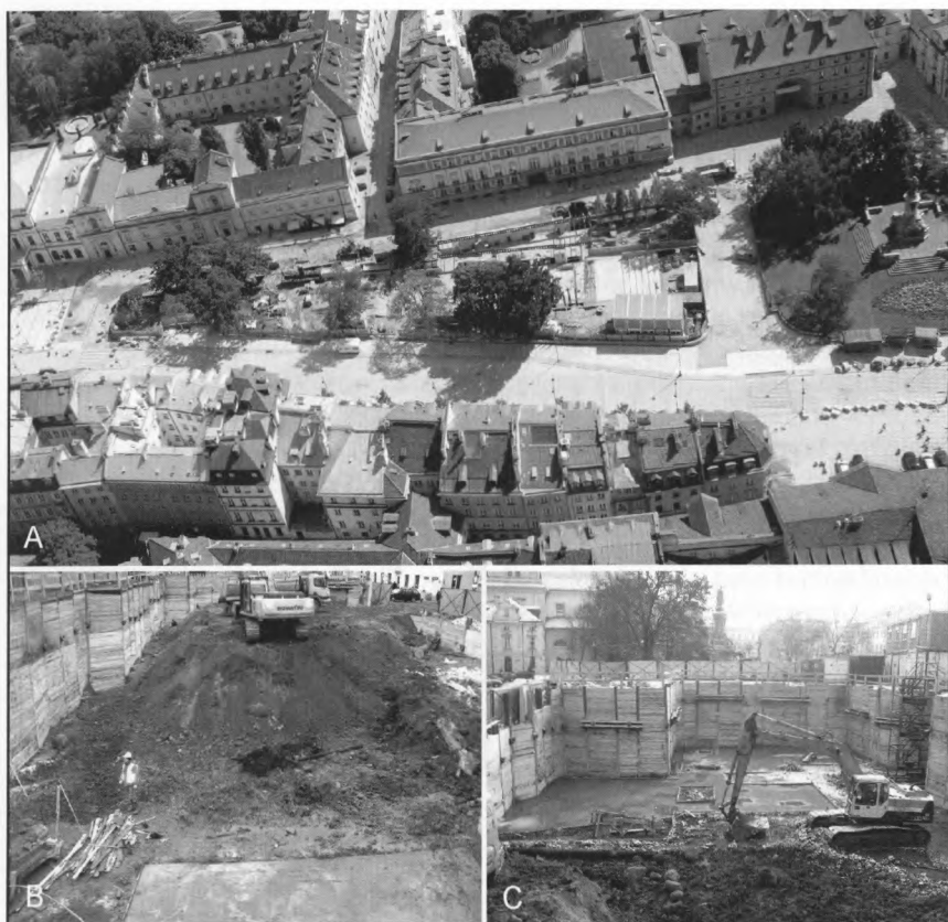
4. Fotografie ogólne wykopu, prace budowlane: A/ fotografia lotnicza Skweru Hoovera (widok od zachodu), B/prace ziemne niszczące dawną zabudowę i nawarstwienia kulturowe, C/wykop po zakończeniu prac ziemnych
