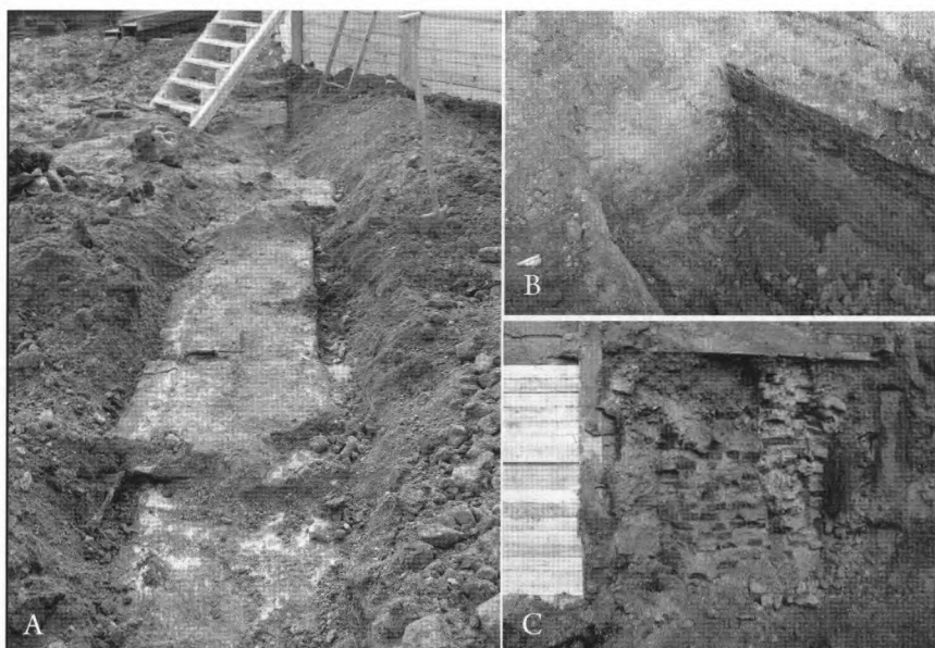
7. Fragmenty dawnej architektury odsłanianej w trakcie prac ziemnych: A/ budynek A, B/ fragment piwnicy budynku D (widok od południa), C/ fragment budynku E (widok od południa)
