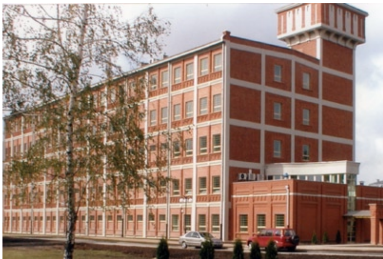
Budynek po remoncie w 2002 r.
