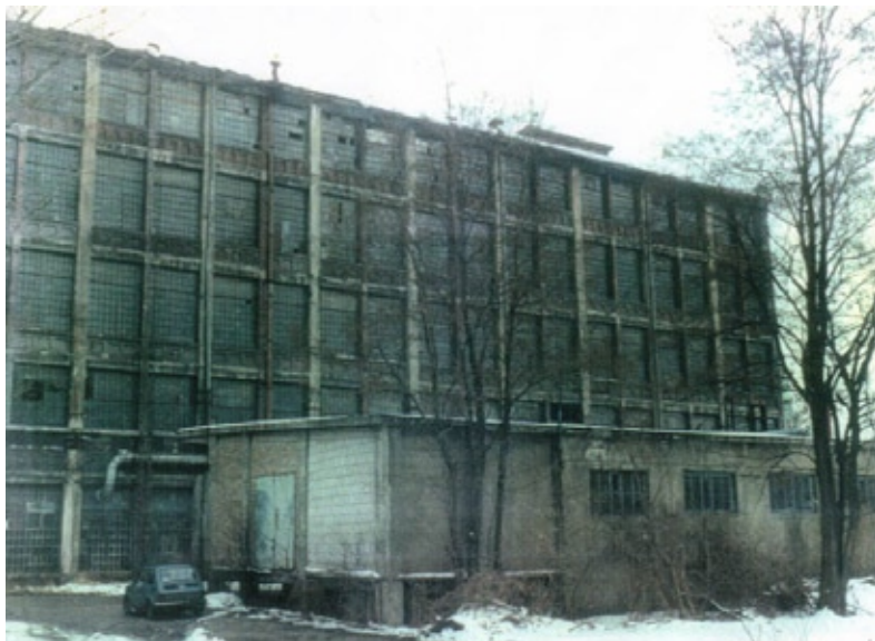
Budynek BPL przed remontem - 1997 r.
