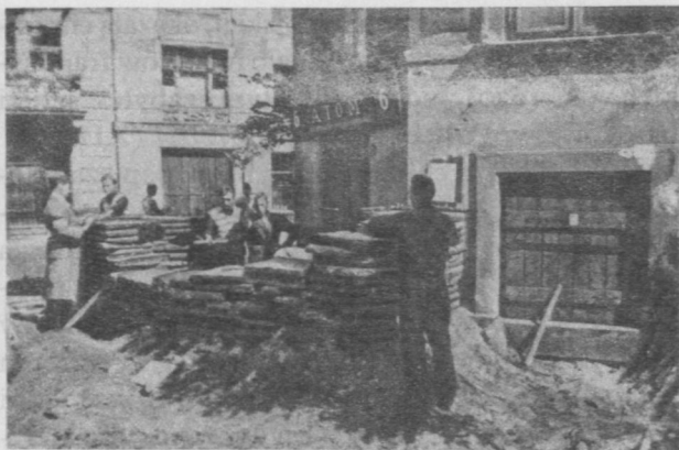
1. Budowa stanowiska ogniowego przy ul. Zgoda. 1. La construction par des sapeurs du poste de feu dans la rue Zgoda.
