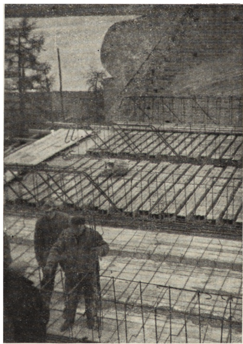
Ryc. 124 i 125. Nieszawa — kościół parafialny. Widok ogólny i zbrojenie stropu w końcu 1951 r.
