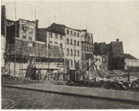
Ryc. 126. Toruń — fragment muru obronnego w czasie konserwacji w r. 1949.
