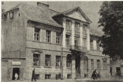
Ryc. 128. Płock — dom przy ul. Narutowicza 8, zwany „Pod Opatrznością“. Stan po wykonaniu częściowej konserwacji.
