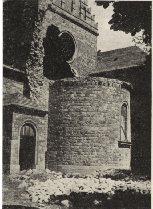
Ryc. 142. Płock — katedra. Fragment odbudowy ściany południowej i kaplicy św. Zygmunta. Stan z r. 1945.
