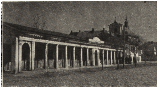
Ryc. 129. Góra Kalwaria — budynek podziemny w Rynku z pocz. XIX w. Stan z r. 1951.
