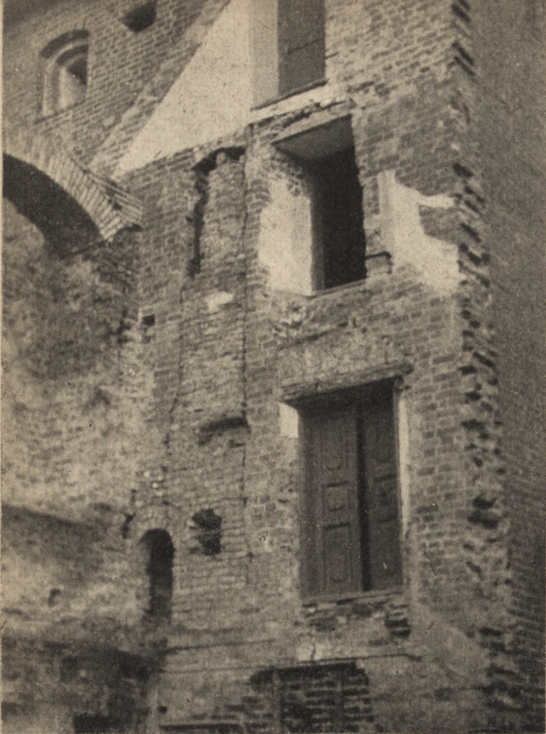
Ryc. 60. Frombork. Wieża Kopernika — fragment ściany południowej. Stan z 1952 r.
