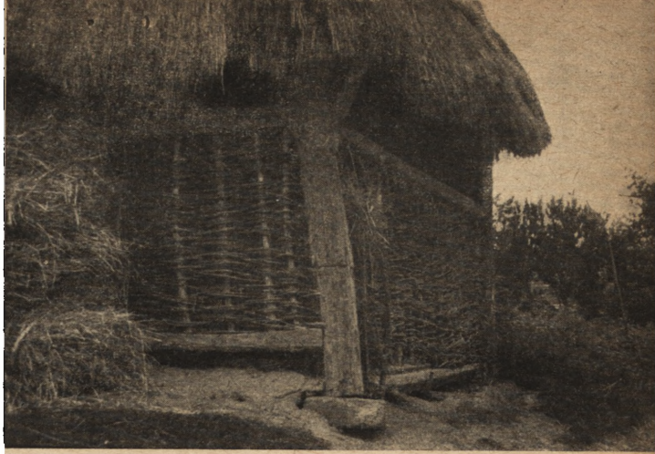
Ryc. 264. Urzejowice, pow. przeworski — stodoła „z płotu“ (II poł. XIX w.).
