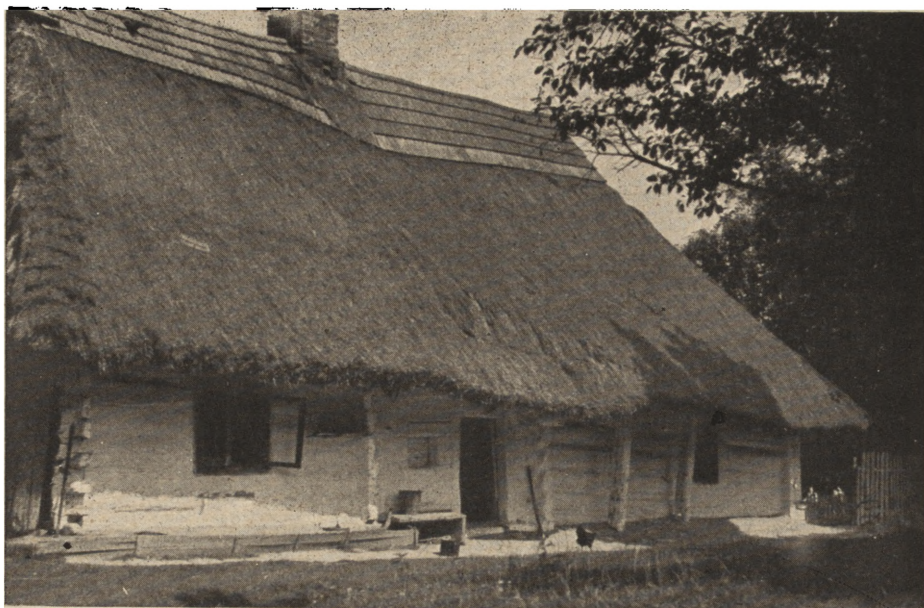
Ryc. 267. Grzeska, pow. Przeworsk — chałupa z pocz. XIX w. Dwa widoczne słupy dodane później, podtrzymują złamaną płatwę. Fot. z r. 1952.
