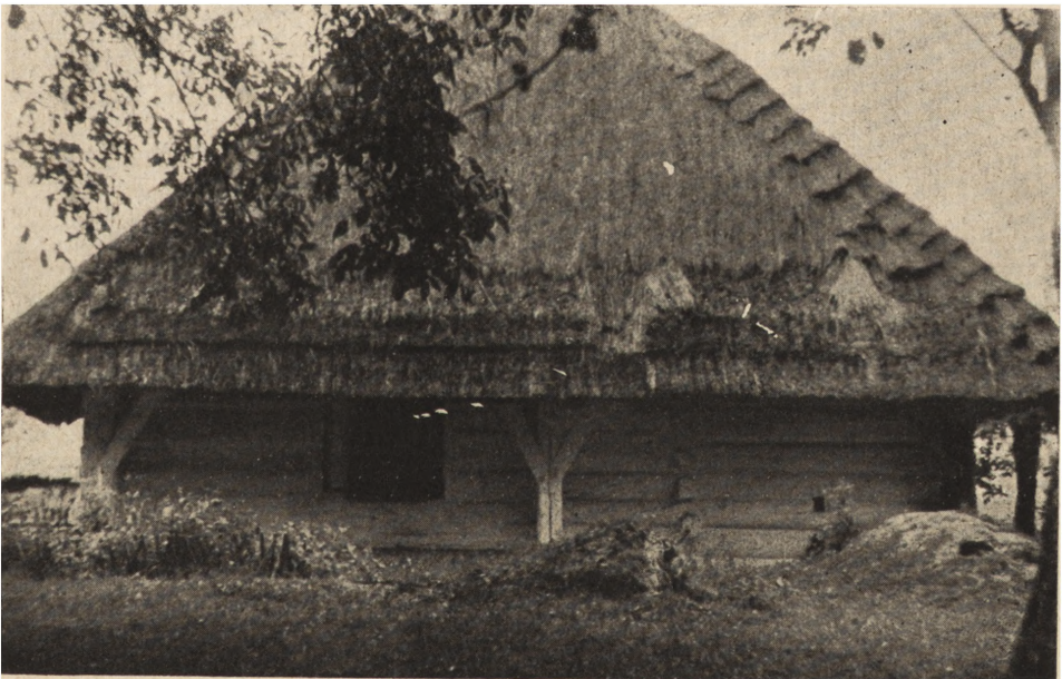
Ryc. 260. Grzęska, pow. przeworski — chałupa. Rygiel i krzyżowe pietnary zostały usunięte po późniejszym wycięciu w ścianie okna.
