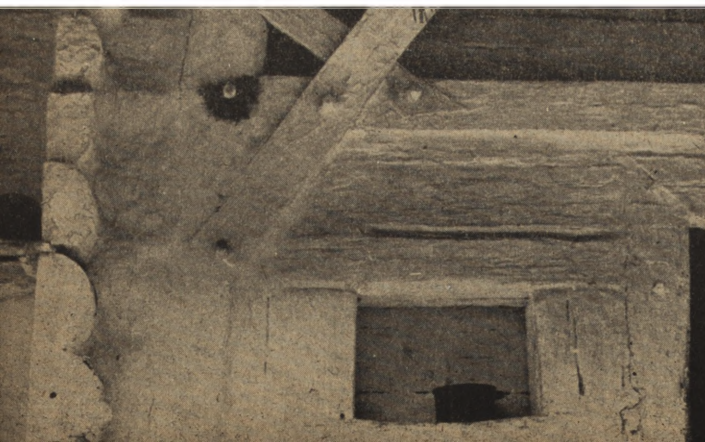
Ryc. 263. Grzeska, pow. przeworski — fragment ścianki tyblowej sieni.
