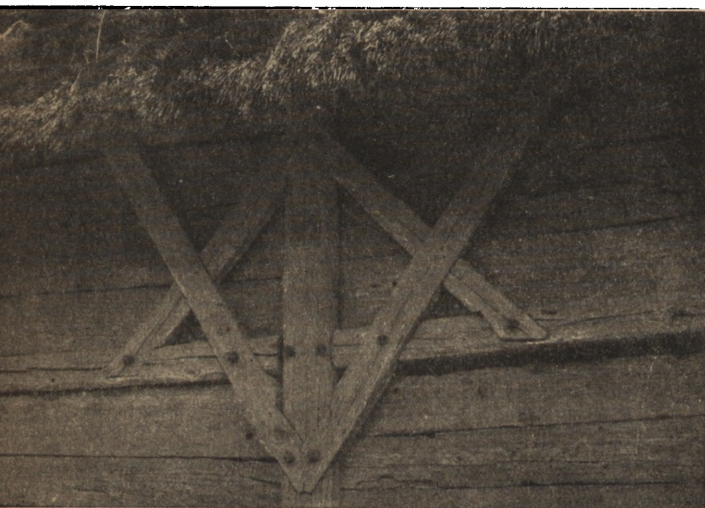
Ryc. 262. Niżatyce, pow. przeworski — środkowy słup z rygłem i pietnarami na krzyż.
