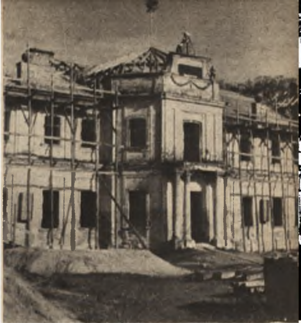
Ryc. 299. Narol, pow. lubaczowski — elewacja frontowa pałacu po odbudowie więźby dachowej. Stan z r. 1952.
