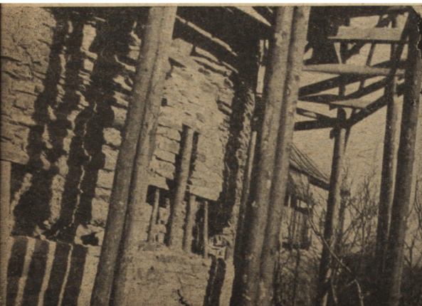
Ryc. 303. Biecz, pow. gorlicki — wieża Katowska. Spód wieży w czasie remontu w 1951 r.
