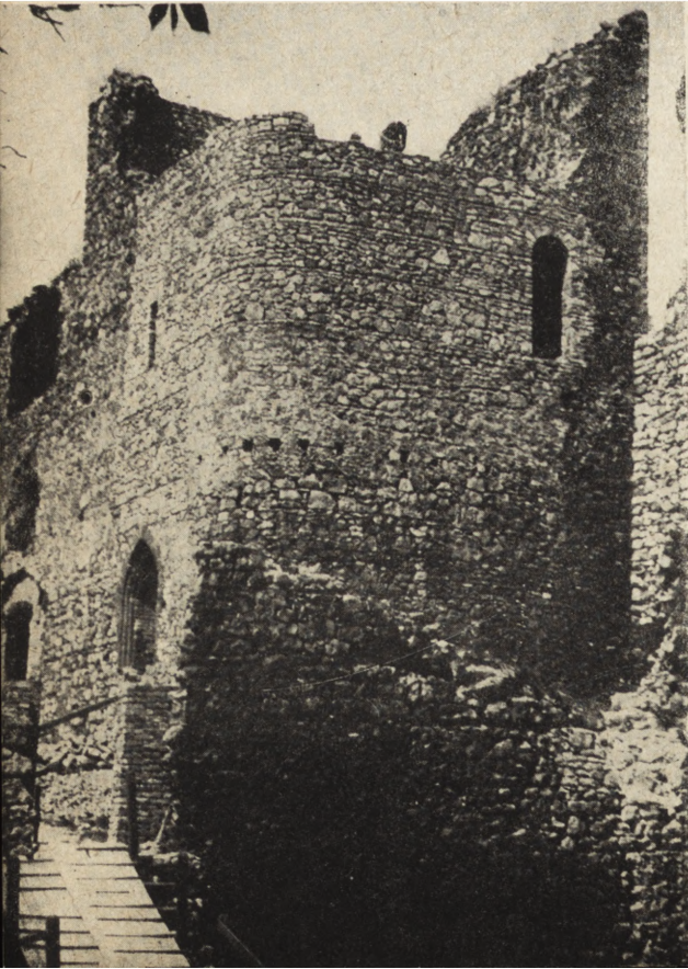
Ryc. 125. Będzin — zamek. Odbudowa baszty.
