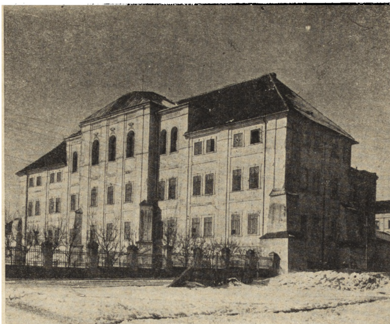
Ryc. 85. Kolegium jezuitów, obecnie liceum im. Bolesława Chrobrego. Widok od południowego wschodu.
