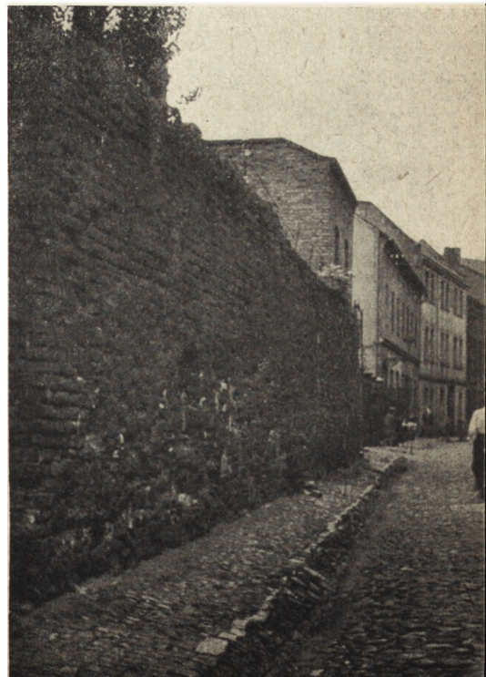
Ryc. 94. Fragment murów warownych przy ul. Grodowej.
