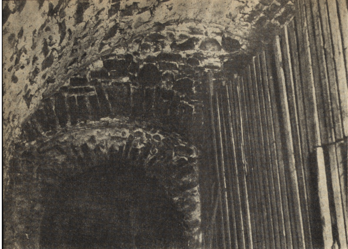
Ryc. 95. Ostrolukowe sklepienia piwniczne. Rynek 12.
