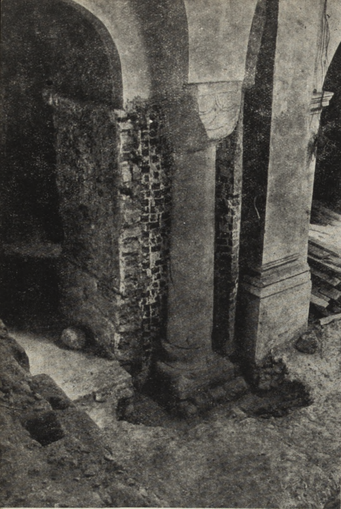
Ryc. 27. Północna kolumna romańska odsłonięta spod obudowy gotyckiej i barokowej.
