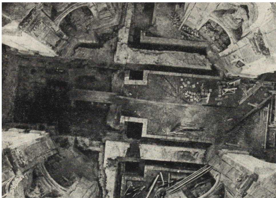
Ryc. 24. Widok z latarni kopuły na odkopane mury chóru romańskiego. Wzdłuż nich murki zabezpieczeń konserwatorskich.
