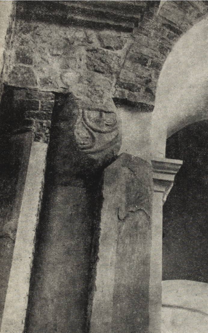
Ryc. 25. Głowica kolumny pd. widoczna w rozkutyj filarze gotyckim. Na filarze resztki stiuków barokowych.
