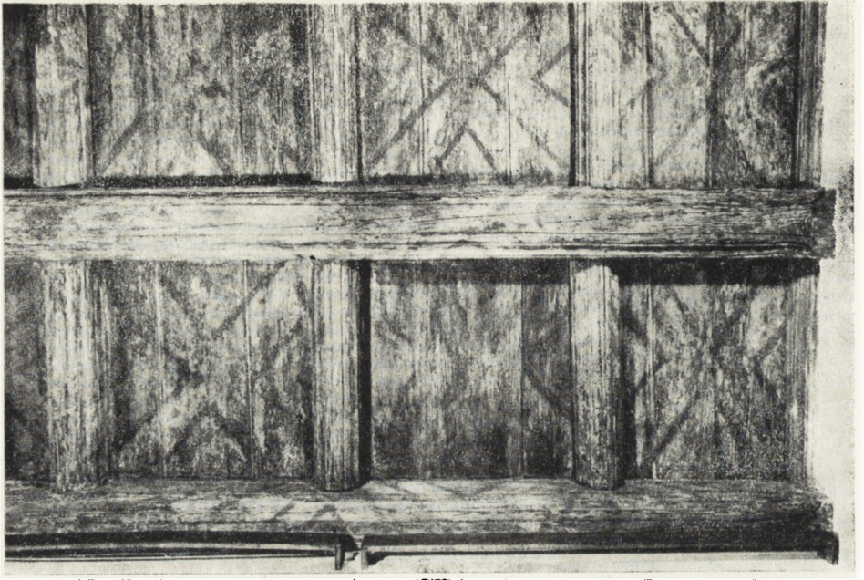
Ryc. 109. Warszawa — Rynek St. Miasta 34. Sześć kasetonów przy ścianie okiennej po konserwacji.
