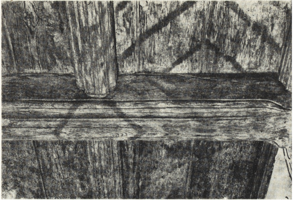
Ryc. 113. Fragment skrzyżowania belek i zakończenie belki poprzecznej przy ścianie, widoczne wraz z polichromią po konserwacji.
