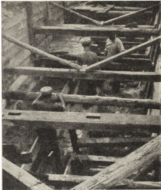
Ryc. 186. Wilanów — Pomarańczarnia. Prace przy kotłowni c. o.
