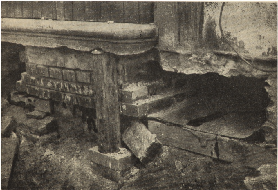
Ryc. 184. Pałac w Wilanowie. Zakładanie izolacji poziomej w korpusie głównym.
