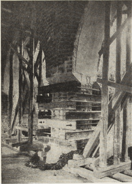
Ryc. 185. Kolegiata w Tumie pod Łęczycą. Zabezpieczanie filara.
