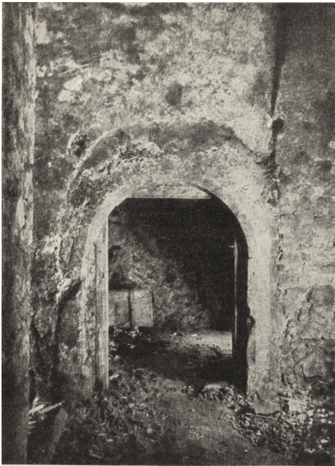
Ryc. 209. Portal w piwnicy Rynek Gł. 12.
