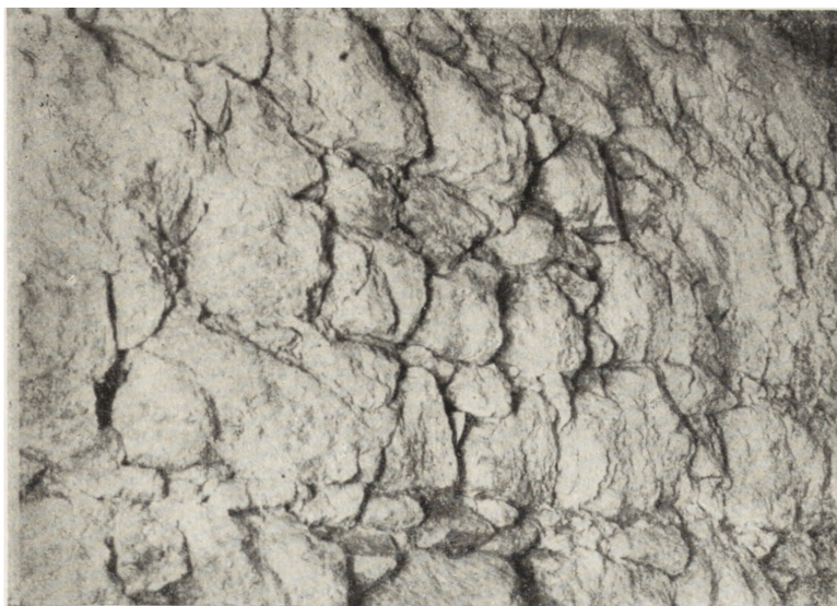
Ryc. 207. Mur kamienny w piwnicy Rynek Gł. 22.
