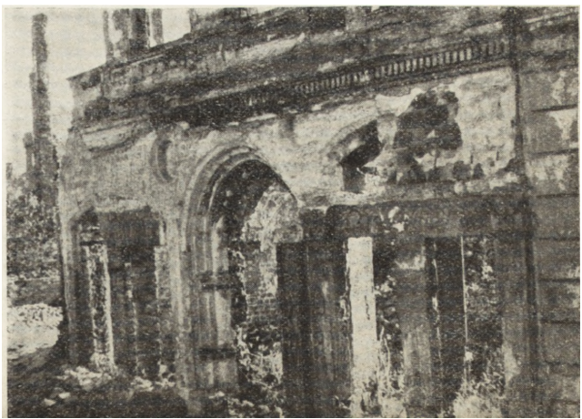
Ryc. 252. Odsłonięte elementy fasady renesansowej domu przy ul. Kuśnierskiej w Szczecinie.
