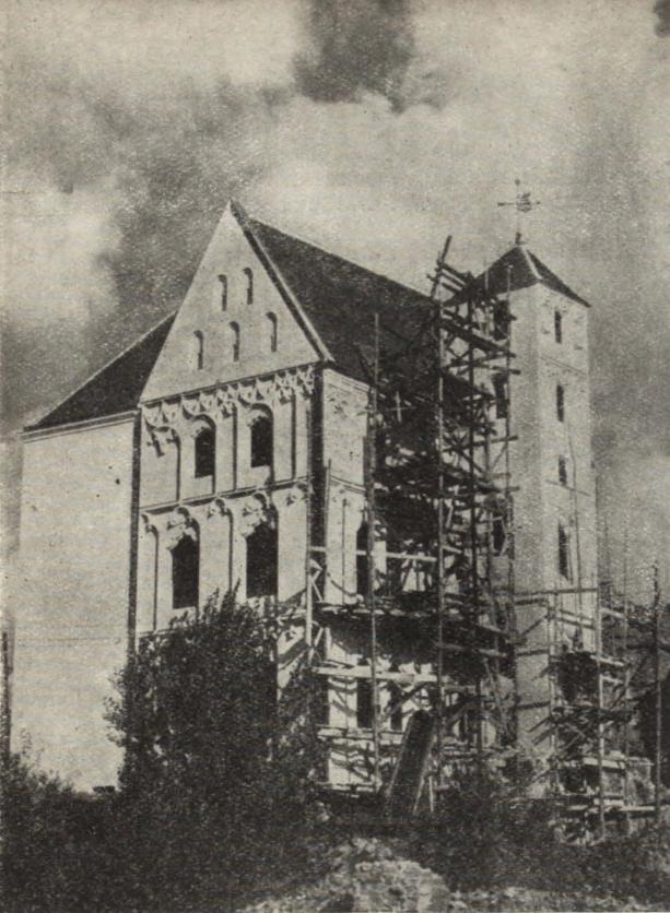
Ryc. 248. Kamienica Loitzów w Szczecinie w czasie odbudowy.
