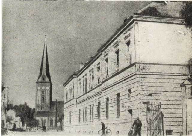
Ryc. 256. Przebudowany budynek nowej poczty w Stargardzie.
