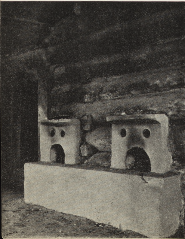
Ryc. 261. Wnętrze sieni z rekonstrukcją systemu ogrzewania.
