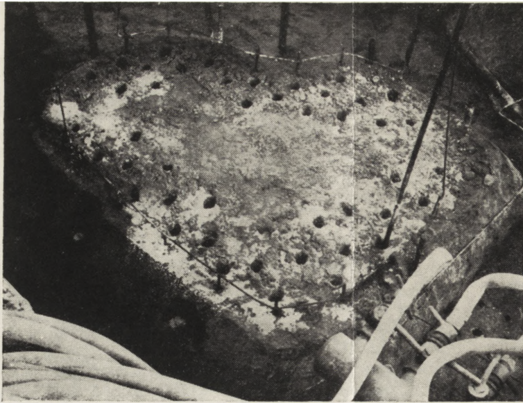
Ryc. 151. Katedra poznańska — obsypka piaskowa jednego z reliktyw. Na zdjęciu widoczne są w piasku otwory do wlewania roztworów chemicznych.
