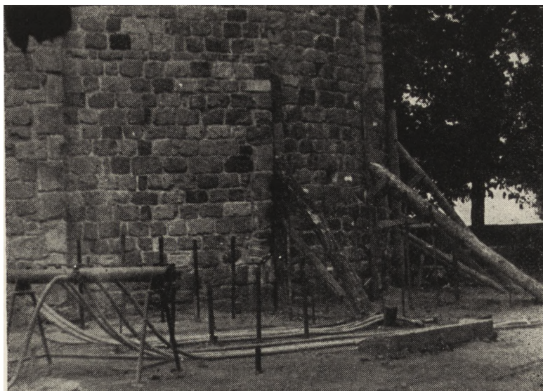
Ryc. 156. Kościół w Gieczu — elektrody rurowe wbite w grunt wokół spękanych ścian absydy.
