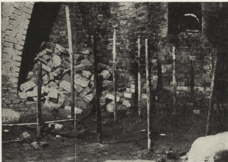
Ryc. 152. Zamek w Kórniku — rozmieszczenie rur żelaznych do nasycania gruntu roztworami chemicznymi.
