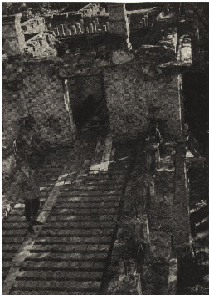
Ryc. 167. Widok ogólny na mury spalonego pałacu.
