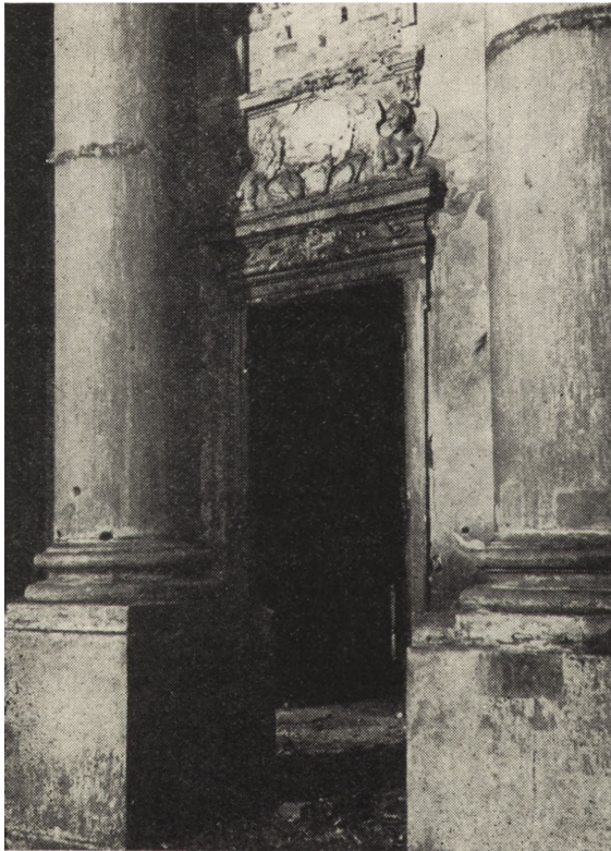
Ryc. 165. Na ścianach i kolumnach przygotowano otwory na ładunki wybuchowe.
