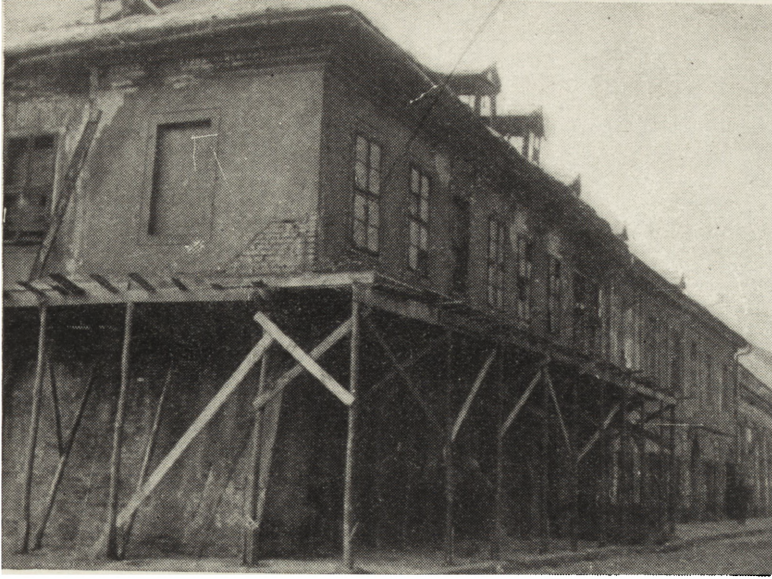
Ryc. 241. Część narożna i fasada domu od strony ul. Józefa. Stan z r. 1952/53 (przed restauracją).
