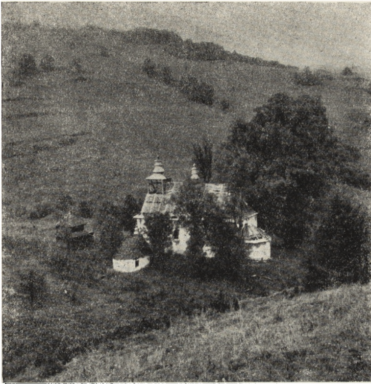
Ryc. 118. Lopienka, pow. leski — cerkiew gr.-kat. z 1757 r. Widok ogólny. W trakcie rozbiórki. Stan z 1955 r.
