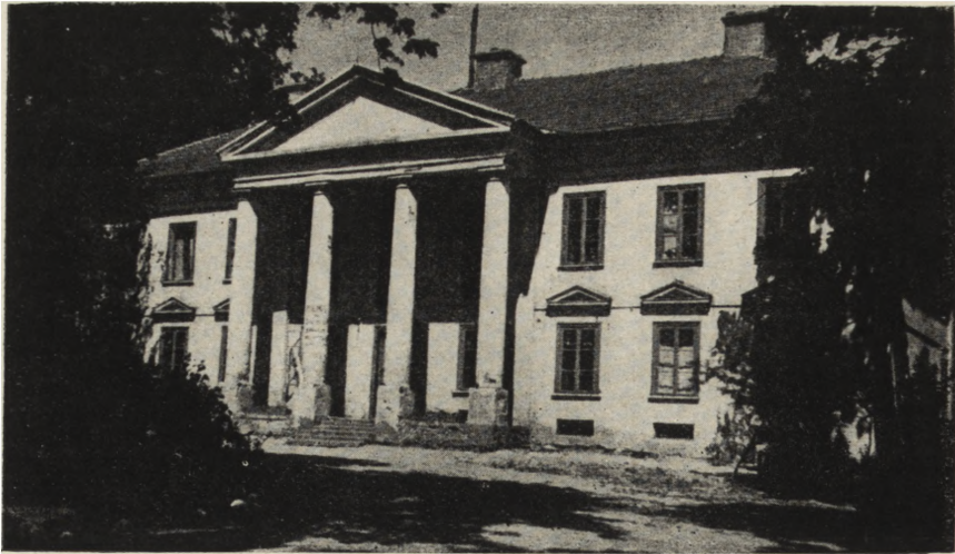
Ryc. 186. Pałac w Rudnie — widok od pd.-zachodu (1950).
