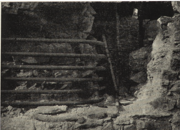
Ryc. 258. Prace przy zakładaniu opaski żelbetowej.
