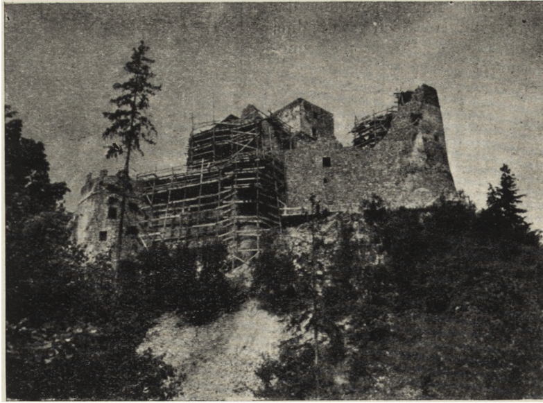
Ryc. 261. Roboty konserwatorskie przy górnym zamku.
