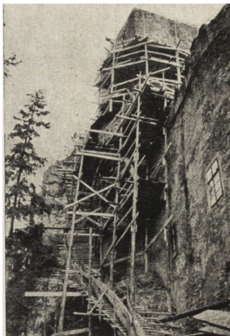
Ryc. 259. Prace przy zakładaniu opaski żelbetowej
