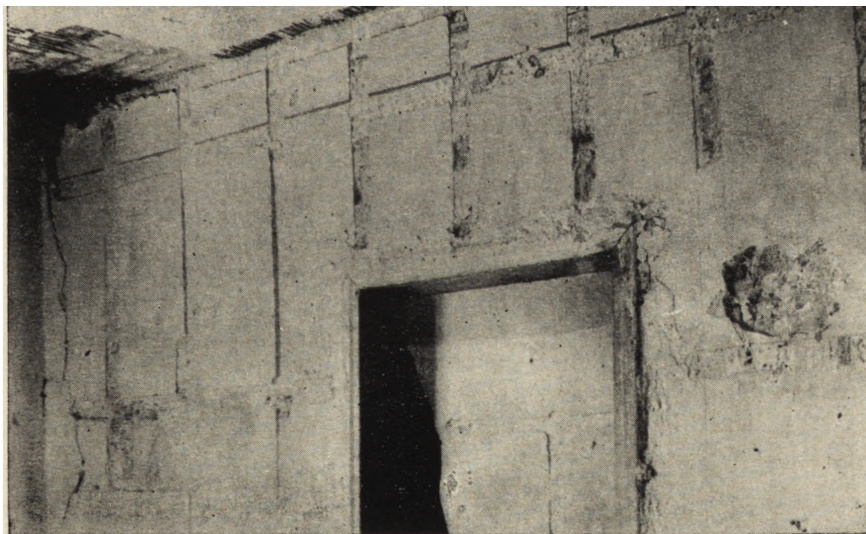
Ryc. 270. Tarnów — Rynek 21. kamienica, System przeprowadzania odkrywek.
