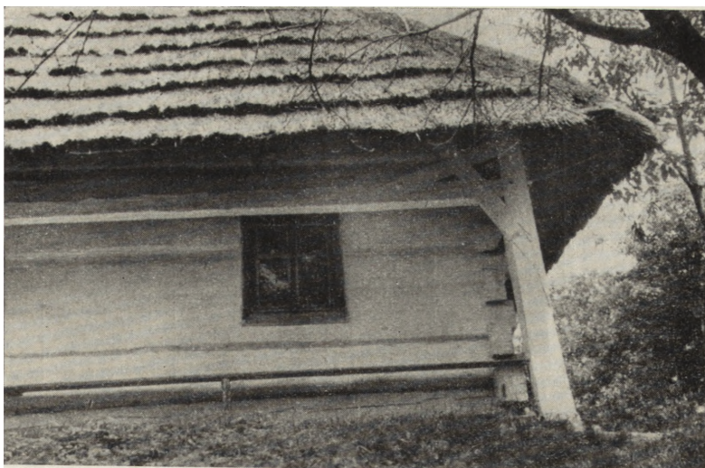
Ryc. 17. Markowa, pow. Łańcut — konstrukcja przysłupowa chalupy, 1956.
