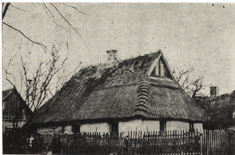
Ryc. 70. Stara chata w Zglechowie — przykład ukształtowania dachu przyczółkowego.
